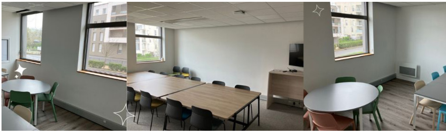
Travaux de réaménagement dans les locaux de SATEC Orléans
